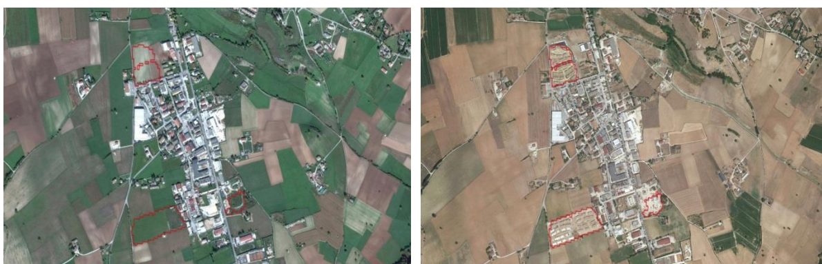
Figura 77 - Soluzioni abitative d'emergenza e moduli prefabbricati per la ripresa dell'attività economica e produttiva o artigianale a San Benedetto (PG). Nel comune si è registrato un consumo di suolo di 9 ettari tra il 2016 e il 2017. Nei 275 km 2 della superficie di Norcia (dove vivono 4900 persone), oltre a 21.000 m 2 riservati a nuovi cantieri, quasi 59.000 m 2 sono stati assegnati per innestare nel territorio comunale – uno di quelli regionali insieme a Castelsantangelo sul Nera attraversati dall'ultimo terremoto dell'Italia centrale – le soluzioni abitative temporanee.
