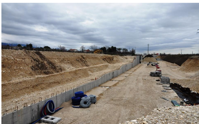
Figura 47 - Cantiere della Pedemontana nei pressi di Paulona, a Sud-Ovest di Vicenza (foto di Paolo Meneghini).
