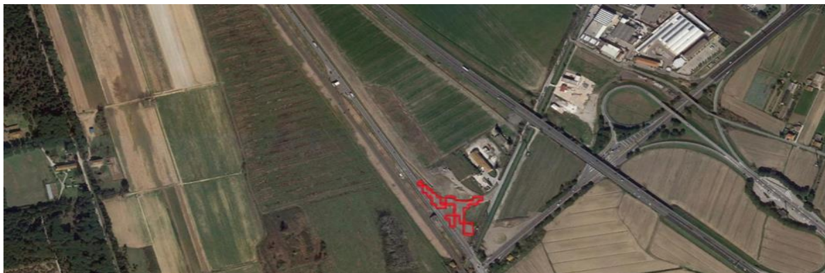
Figura 73 - A seguito dell'alluvione verificatasi in Provincia di Pisa nel 2016 è stato messo in opera il raddoppio della strada statale Aurelia nel Comune di Vecchiano, la cui dismissione avverrà verosimilmente nell'arco di pochi anni. Nel caso in oggetto il nuovo consumo di suolo, pur presentando tutte le caratteristiche per essere classificato come non reversibile, è destinato alla rimozione a seguito della dismissione dell'infrastruttura.
