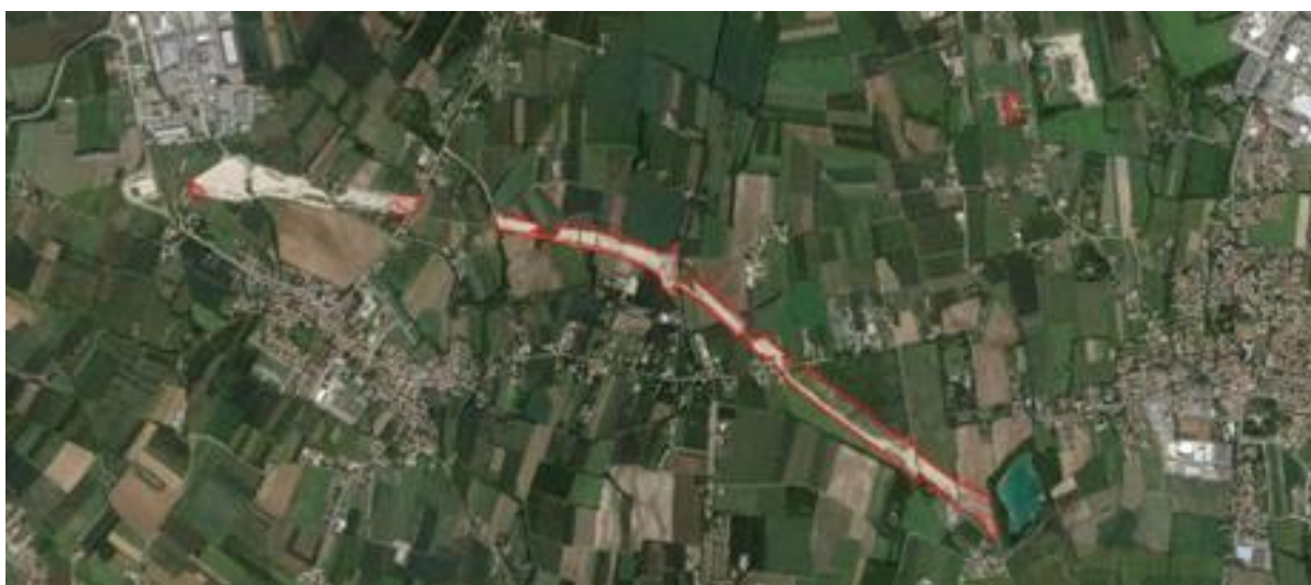
Figura 46 - Cantiere della Pedemontana nei pressi di Povegliano e Villorba (TV); nel 2017 i cantieri della pedemontana hanno occupato circa 127 ettari tra le province di Treviso e Vicenza, che sommati ai 350 ettari degli anni precedenti portano a un totale, ad oggi, di 477 ettari.
