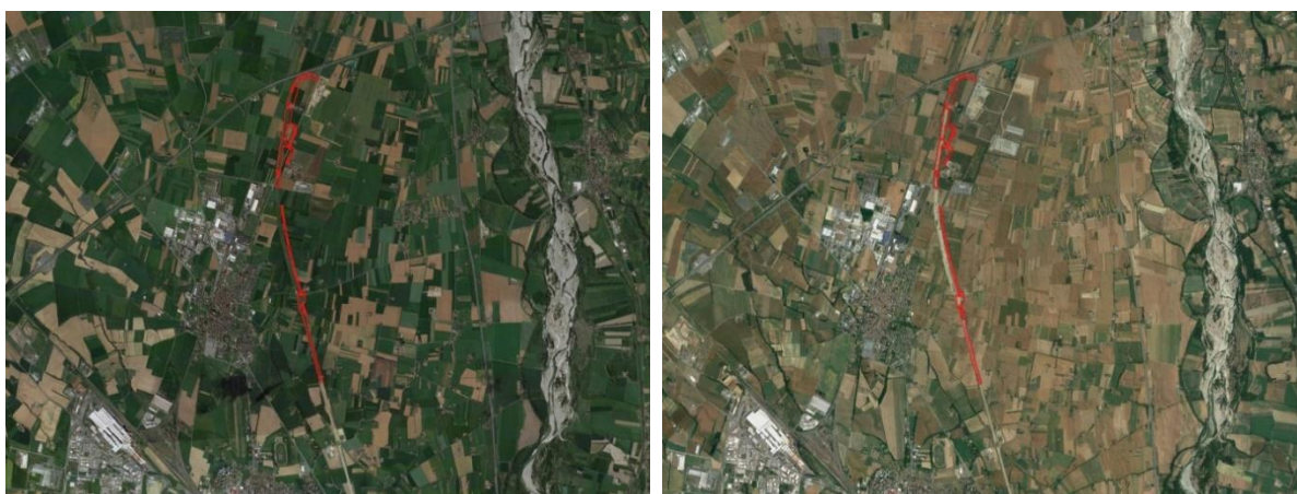
Figura 29 - Tracciato del Terzo Valico dei Giovi che attraversa il territorio di Pozzolo Formigaro che, in provincia di Alessandria e con una superficie di 36 km 2 per 4.700 abitanti, è uno degli 11 Comuni, tra le province di Alessandria e Genova, investiti dai lavori di questa infrastruttura intermodale transeuropea: con una lunghezza complessiva di 53 km e dal costo di oltre 6 miliardi di euro, dovrebbe collegare i porti del Mare del Nord con il porto genovese attraversando la valle del Reno, Basilea e Milano. Lo sviluppo del primo lotto ha richiesto l'utilizzo di un'area di 34 ettari.
