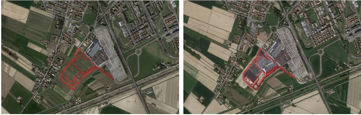
Figura 69 - Ampliamento di uno dei centri commerciali più grandi del Paese, da quasi 75.000 m 2 , con una significativa perdita, per la sua realizzazione, di diversi ettari precedentemente destinati all'agricoltura sul territorio comunale di Ravenna.
