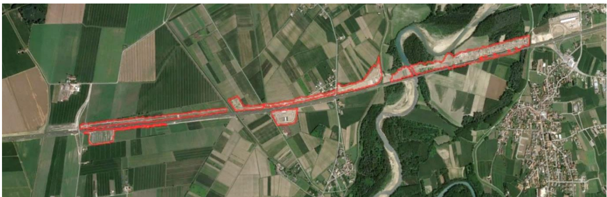
Figura 57 - Il tratto dell'autostrada A4 Torino-Trieste che attraversa il territorio di San Michele al Tagliamento dove, nell'ultimo anno, sono stati artificializzati quasi 34 ettari di suolo naturale, 22 dei quali per questa nuova grande opera.
